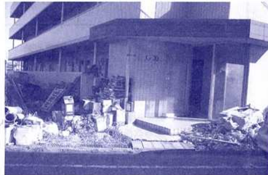
管理崩壊、上下水エレベーター止まる(藤岡市)
