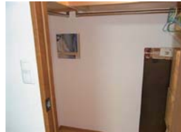
C:隣接浴室クローゼット奥排水たて管
