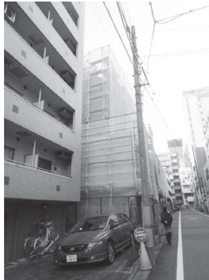
新宿・N賃貸マンションの工事現場
