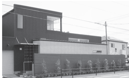
市との話し合いで植え込みを家屋側に作り替え、さらに外壁との間に高さ2mの塀を設け騒音を防ぐ。
